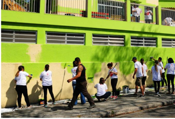
Rénovation des locaux de plusieurs ONG au Brésil
